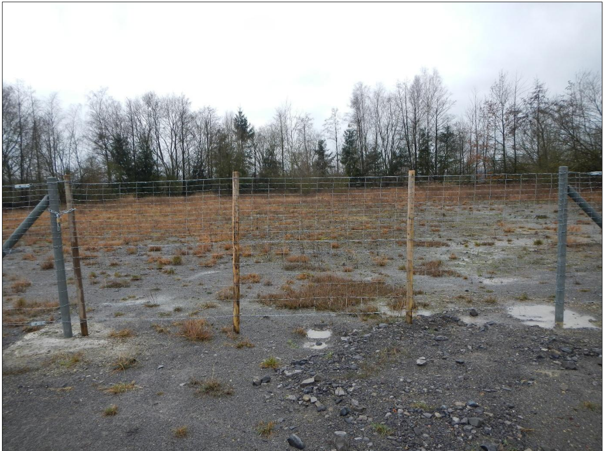
Abb. 10: Beispielbild eines Zugangstores aus Weidezaungitter mit verstärkten Eckpfählen
