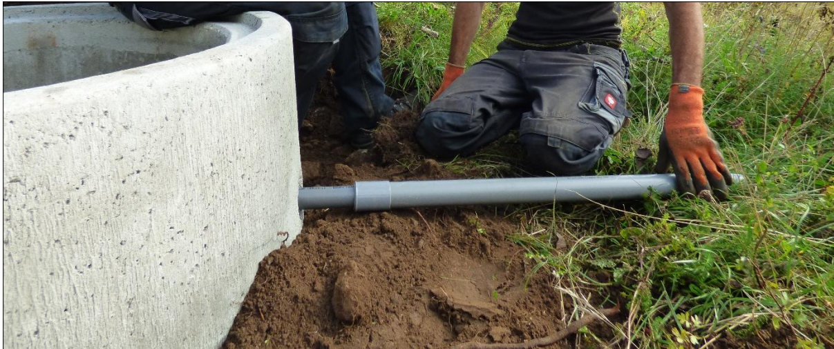
Abb. 7: Montierte Ablassereinrichtung an der Außenwand des Brunnenrings
