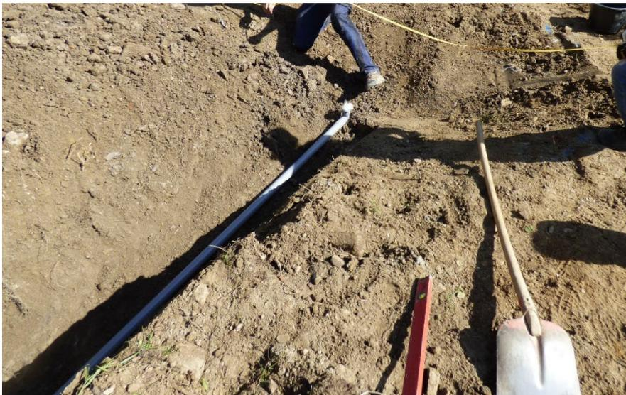
*Einbau der Ablasseinrichtung der Folien-/Ortbetongewässer. An die Biegung, zu sehen neben dem Fuß der Person, wird das Standrohr welches mit der EPDM Folie verschweißt ist angeschlossen (siehe folgende Abbildung).*
