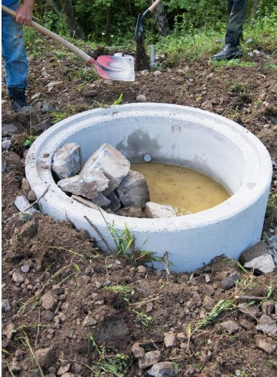
*Beispielfoto eines Brunnenringes mit Gummistopfen. Die umgebende Erdoberfläche wird noch bündig bis zur oberen Kante angefüllt.*
