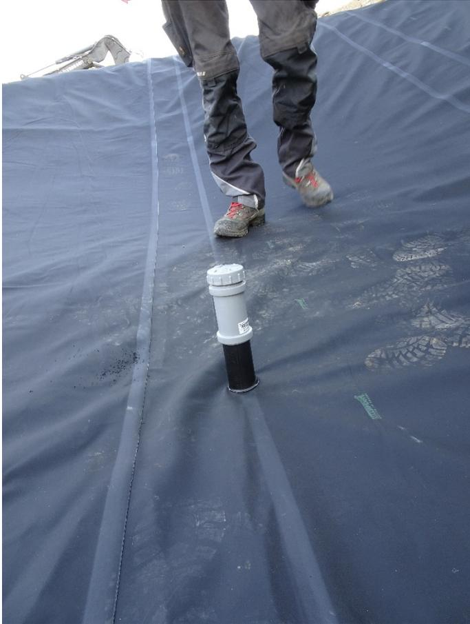
*Standrohr mit Schraubkappe eingeschweißt in die EPDM-Gewässerfolie.*
