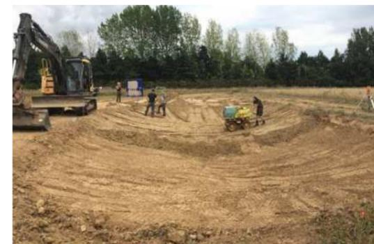
▶ Bei dem bentonithaltigen Material Dernoton® ist eine gute Verdichtung sowie eine anschließende Überdeckung sehr wichtig.
