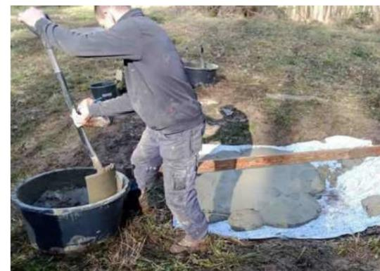
▶ Solange der Gewässerdurchmesser ca. 1,5 m nicht überschreitet und die Ufer sehr flach sind (z.B. für Kreuzkröte und Gelbbauchunke), kann Beton mit 0-1 mm Körnung direkt vor Ort von Hand eingebaut werden (Materialstärke: > 5 cm). Ab ca. 1,5 m Durchmesser werden Dehnfugen notwendig.
