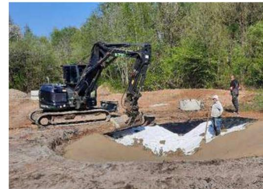
► Anlage eines EPDM-Foliengewässers mit einer Betonschutzschicht mit Kunststofffasern. Ein Geotextil schützt die Folie gegenüber dem Erdreich und dem Beton.
