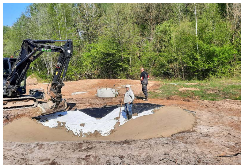
Abb. 5: Bau eines EPDM-Foliengewässers mit einer Betonschutzschicht. Die Gewässer sind in Größe und Tiefe variabel gestaltbar. Foto: Wil Niessen
