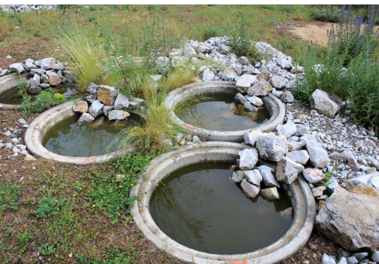
Abb. 4: Kleingewässer aus Brunnenringen (Fertigteile) verfügen über einen nachträglich eingebauten Ablass. Foto: Wil Niessen
